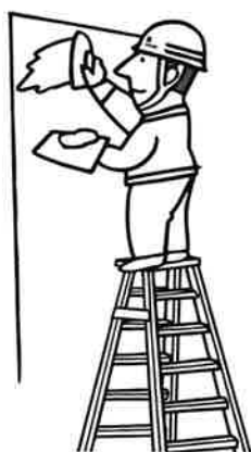
天板での作業 × 作業高さに合った脚立の使用 ○
