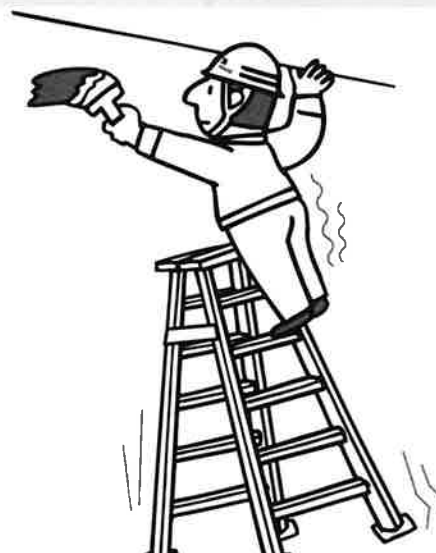
身を乗り出して作業し転落
